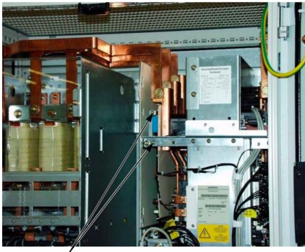
Рис. 4-4 Удаление соединительной скобы к помехоподавляющему конденсатору
